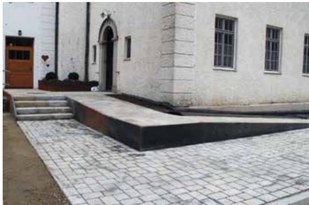
In Kürze werden an der Rampe, an der Treppenanlage und beim Eingangspodest die notwendigen Geländer gefertigt und montiert.
