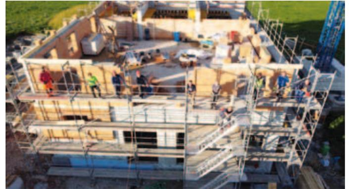
Am Tag darauf wurde dann im Obergeschoss alles inklusive der Innenmauern fertig hochgezogen. Mittlerweile sind drei Stockwerke mit Innenwänden fertig gemauert. Die Fenster für das Kellergeschoss sind fertig.
