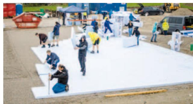
Das Foto oben entstand am 1. Tag beim Legen der Bodenisolierung unter der Betonplatte. Das Foto unten zeigt den betonierten Probenraum mit den großen Fenstern am 2.9.2020.
